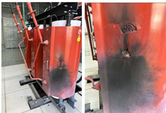
Figura 1 – Transformador Auxiliar TSA1 da Subestação Campinas avariado – 10/06/2023
