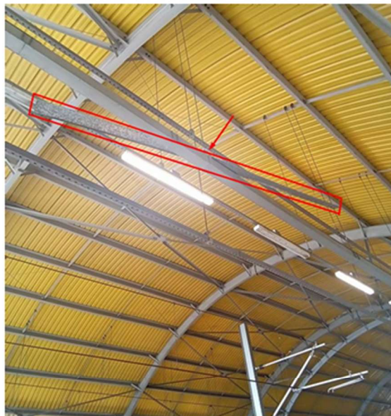
Imagem 2 – Tampa de eletrocalha solta na Estação Campinas- Plataforma 1
